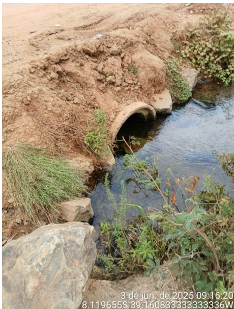
Figura 17 – km 5,5 – LE - 2 tubos Ø 0,60 m
