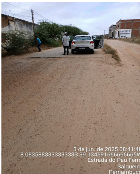
Figura 12 – Pavimento em paralelepípedos construído pela AMBEV com 7,0 m de largura
