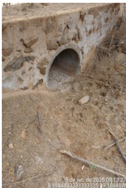
Figura 15 – km 5,3 – BSTC 1,00 m – LE, seco
