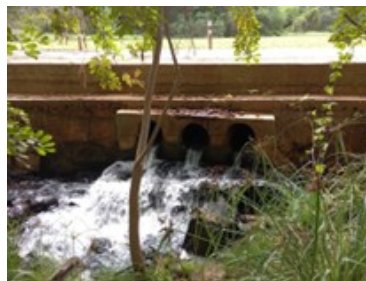
Figura 5 – Passagem molhada com bueiro dois bueiros triplos nas coordenadas 24 L 476924.00 E e 9096142.00 S.
