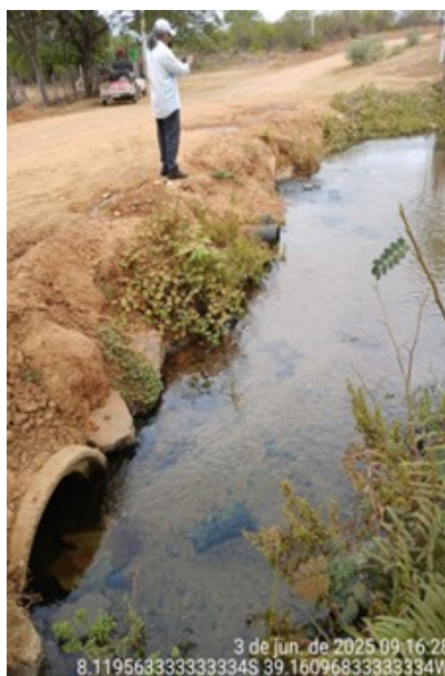
Figura 16 – km 5,5 – LD - 2 tubos Ø 0,60 m
