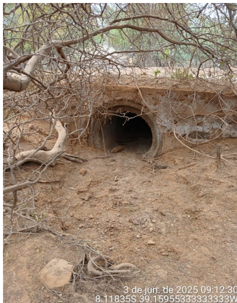
Figura 14 – km 5,3 - BSTC 1,00 m – LD, seco
