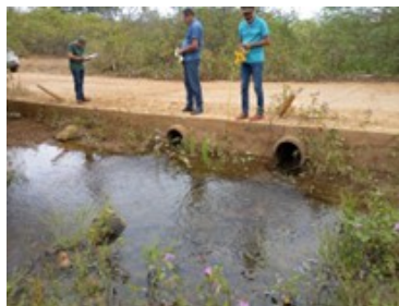
Figura 4 – Passagem molhada com bueiro duplo nas coordenadas 24 L 481295.00 E e 9101786.00 S.
